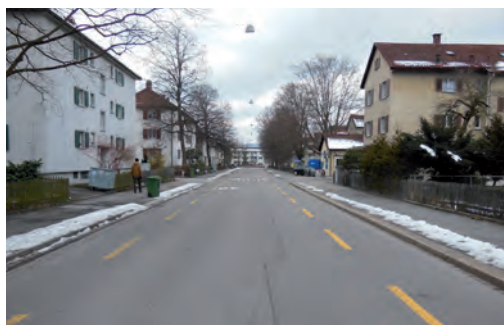
Blick Richtung Nordwesten auf der Wartstrasse. Die Velostreifen werden demarkiert, damit den Velofahrern die gesamte Fahrbahn zur Verfügung steht. Evtl. sind zur Verkehrsberuhigung zusätzliche Massnahmen nötig.
