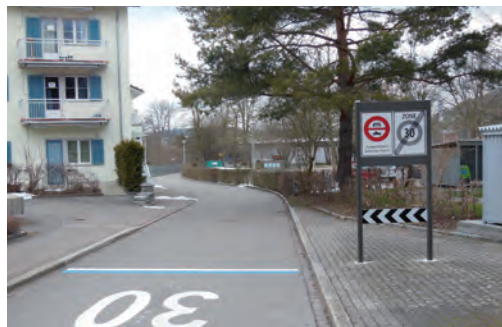
Blick Richtung Nordosten auf die kurze Engstelle. Rechts angrenzend an die Strasse soll der separate Gehweg erstellt werden.
